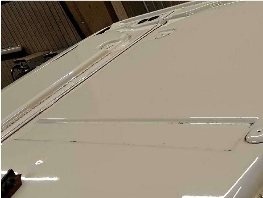
Bild 53 Dach Dach Delle
