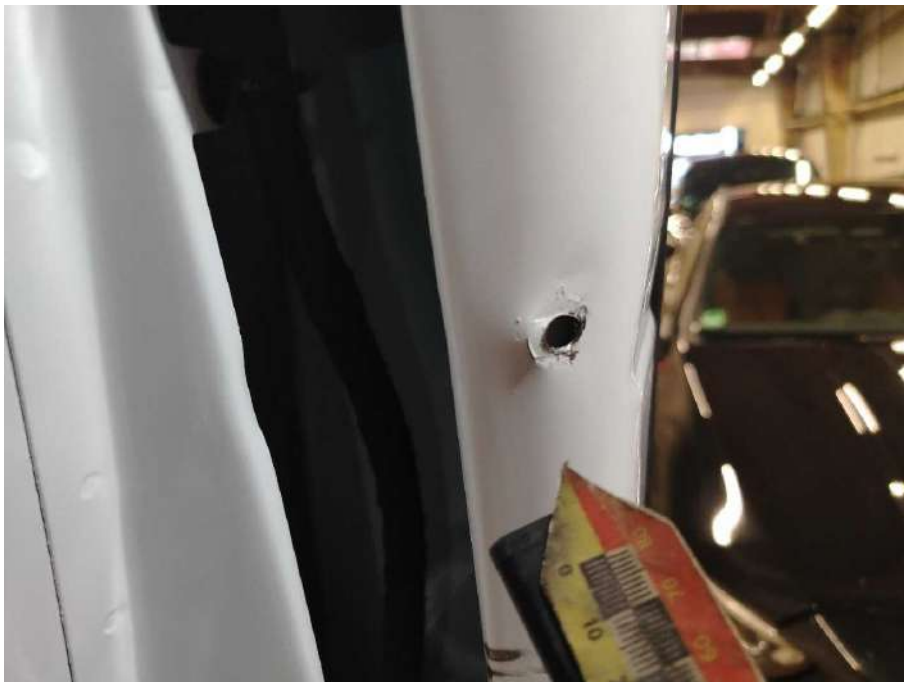
Bild 30 rechte Seite D-Säule rechts beschädigt
