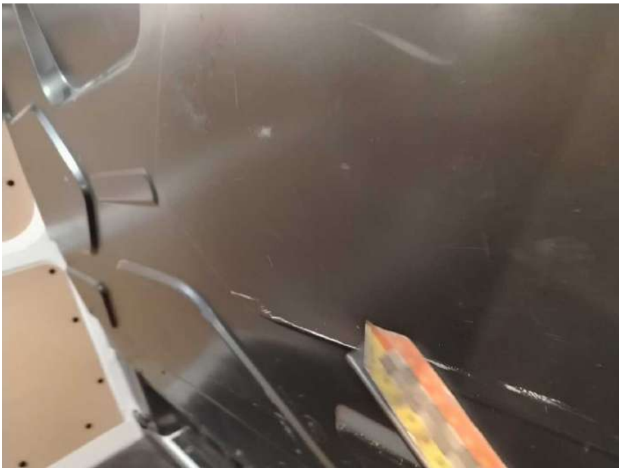
Bild 36 Fahrzeug Trennwand Laderaum verformt
