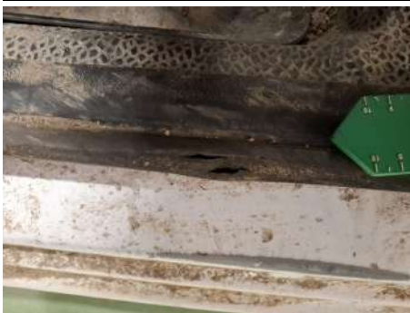
Deurkozijnafdichting / Vooraan links / Scheur
