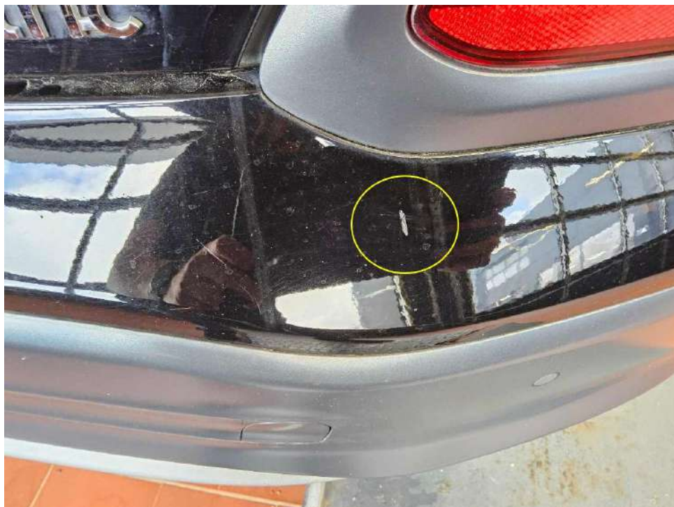
Bild 36 : Stoßfänger hinten, zerkratzt
