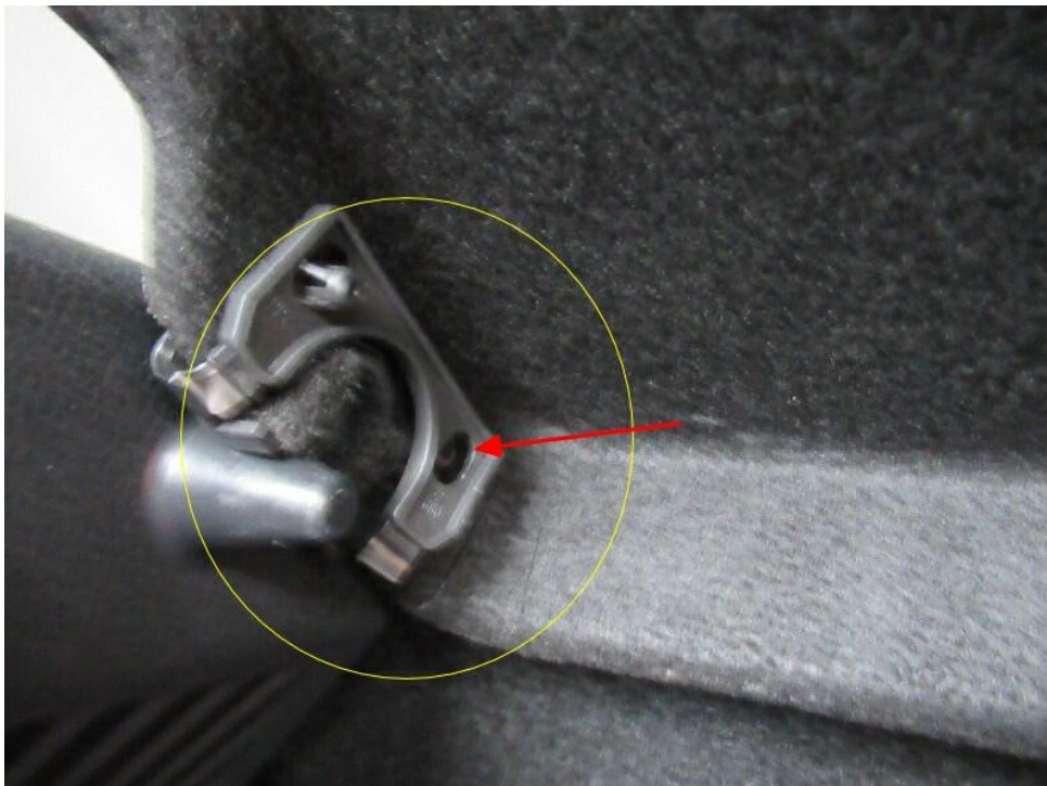
Bild 8 : Innenraum, Hutablage, Halterung links gebrochen
