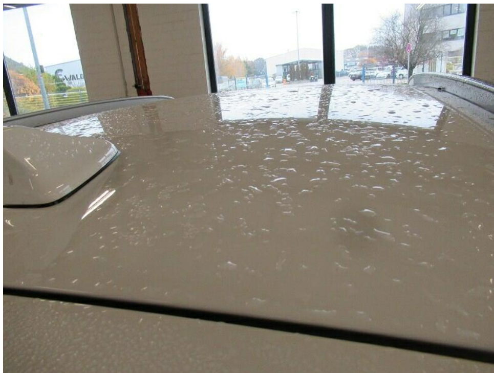
Bild 5 : Dach von hinten nach vorne
