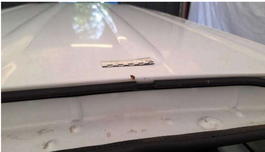
Bild 22 Dach Dachhaut korrodiert
